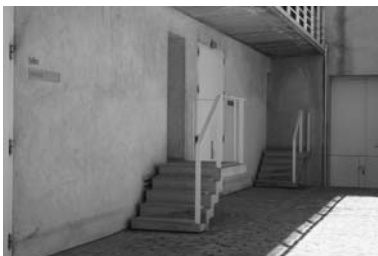
Escaleras de acceso a las entreplanas de los talleres de restauración del IAPH. Proyecto: G. Vázquez Consuegra (Fuente: MGCG, 2012)
