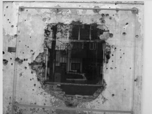
Vidrio de protección superpuesto al hueco existente soportado por estructura de acero galvanizado. (Fuente: MGCG, 2011)
