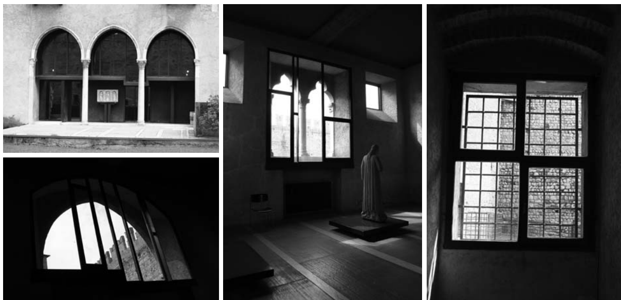
Detalles de las carpinterías introducidas por Scarpa en Castelvecchio (Fuente: MGCG, 2009)
