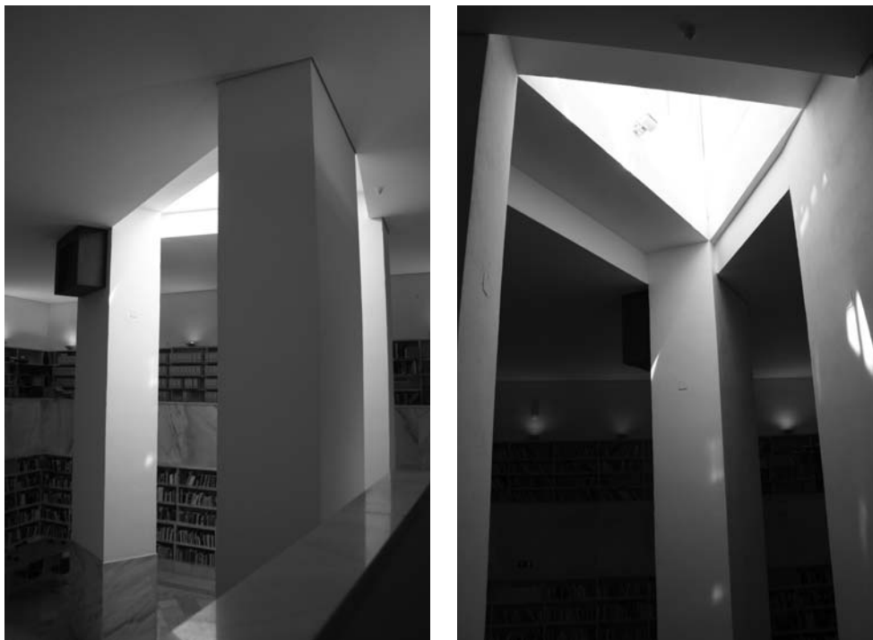
Lucernario de la biblioteca. Estructura de pilares de sección cuadrada que conforman un triángulo base del hueco de luz. (Fuente: MGCG, 2012)
