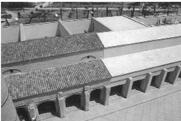
Encuentro de las cubiertas del Claustro. (Fuente: La Car-tuja Recuperada)
