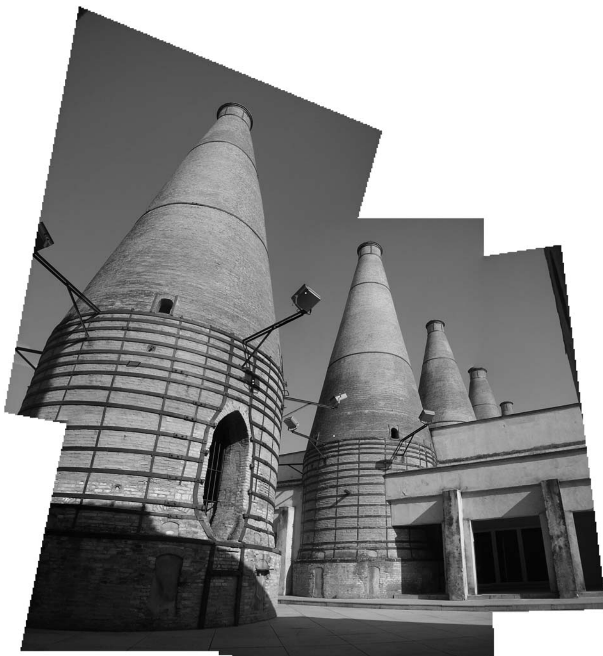
Chimeneas de la fábrica de Pickman. Encuentro con el claustro (Fuente NSA, 2010)
