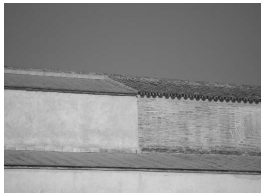
Detalle del encuentro entre los restos conservados del Claustro. (Fuente: NSA, 2010)
