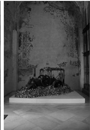
Intervención sobre la pintura mural de la Iglesia. (Fuente: MGCG, 2011)
