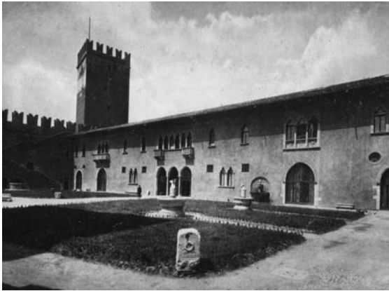
Vista general del Museo de Castelvechio antes de la intervención de Scarpa donde puede apreciarse la existencia de una escalera (de época napoleónica) apoyada en la muralla de la ciudad. (Fuente: CRIPPA, 1984)
