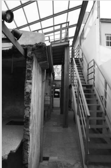
A la izquierda, escalera de acceso a las pasarelas que registran la cubierta proyectada en la parte lateral del patio (Fuente: MGCG, 2011)
