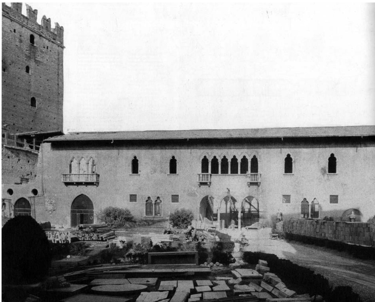
Demoliciones llevadas a cabo en Castelvechio durante el proceso de ejecución de las obras del proyecto de Scarpas. (Fuente: AMC, DI LIETO, 2006)
