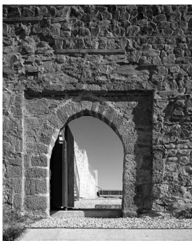
Entrada al castillo de Cala (Sevilla), intervenido recientemente por el estudio de arquitectura republica_dm . (Fuente: Jesús Granada)
