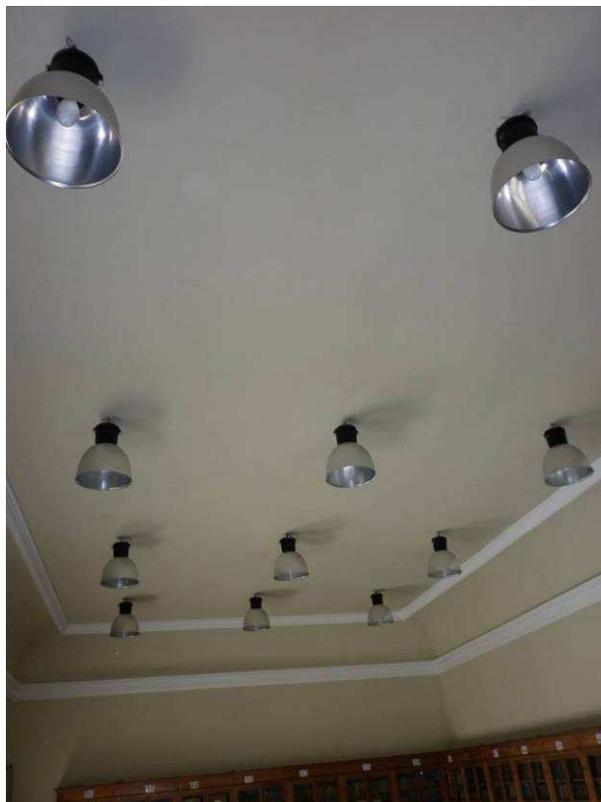
Vista del sistema de iluminación de halogenuros metálicos.
