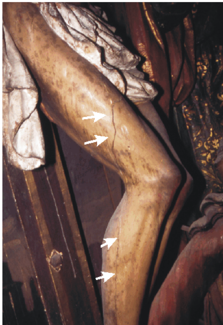
Fisura en la unión de piezas.
