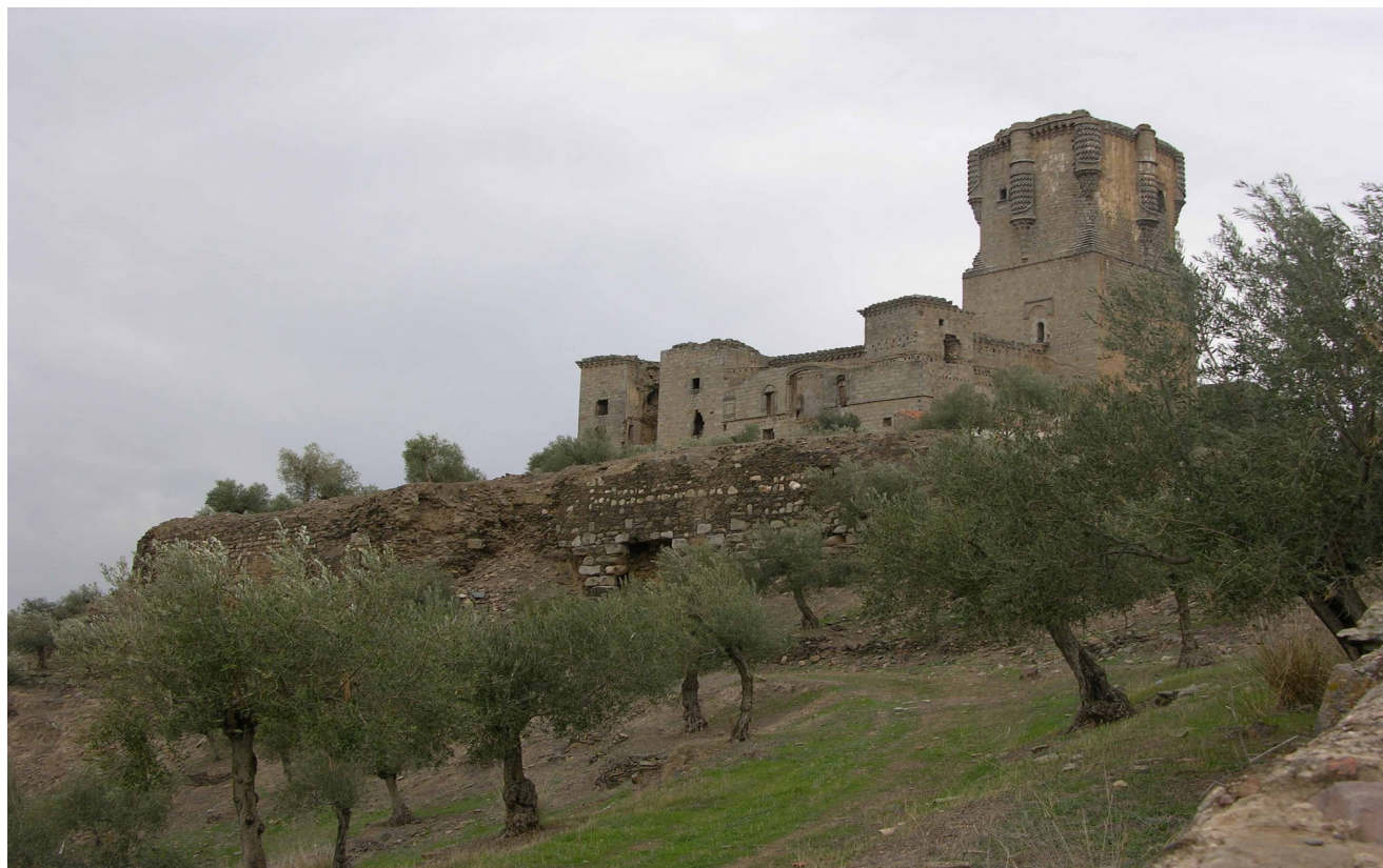
La singular torre del castillo de Belalcázar es uno de los elementos que con mayor fuerza define el paisaje del lugar, manteniendo una clara evocación a la antigua actividad de la defensa.
