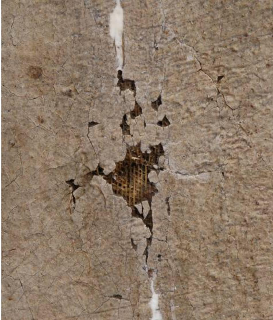
**DATOS TÉCNICOS.** Detalle de la gasa de refuerzo que se utiliza en las costuras originales.
