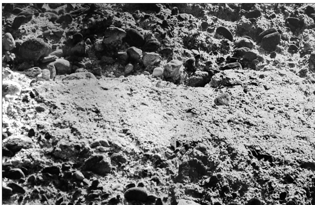
Hormigón de cal visto a visu
