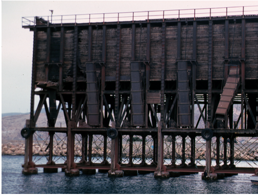
9. Cargadero de mineral, Almería. IAPH
