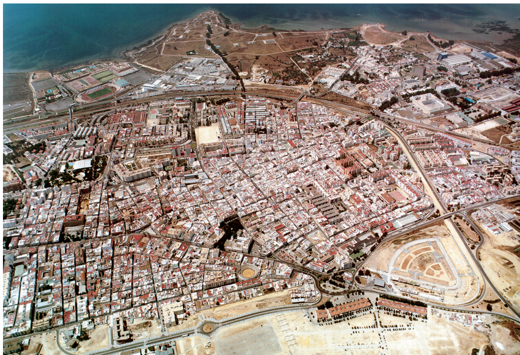
1. Fotografía aérea del Conjunto Histórico San Fernando, Cádiz. IAPH
