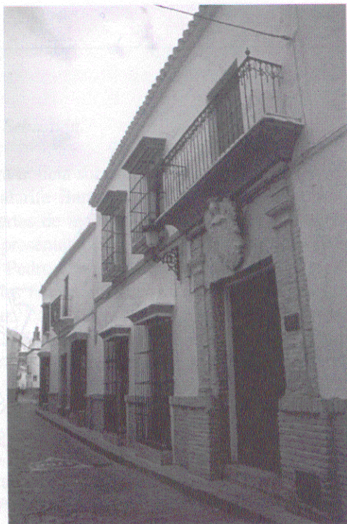
2.-Casa del Escudo, calle Carrera, 19. Fachada.
