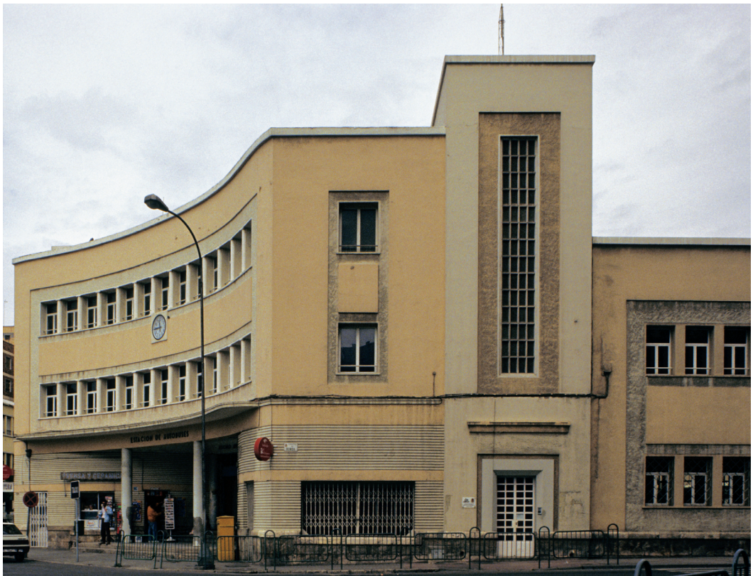
17. Estación de autobuses de Almería. IAPH
