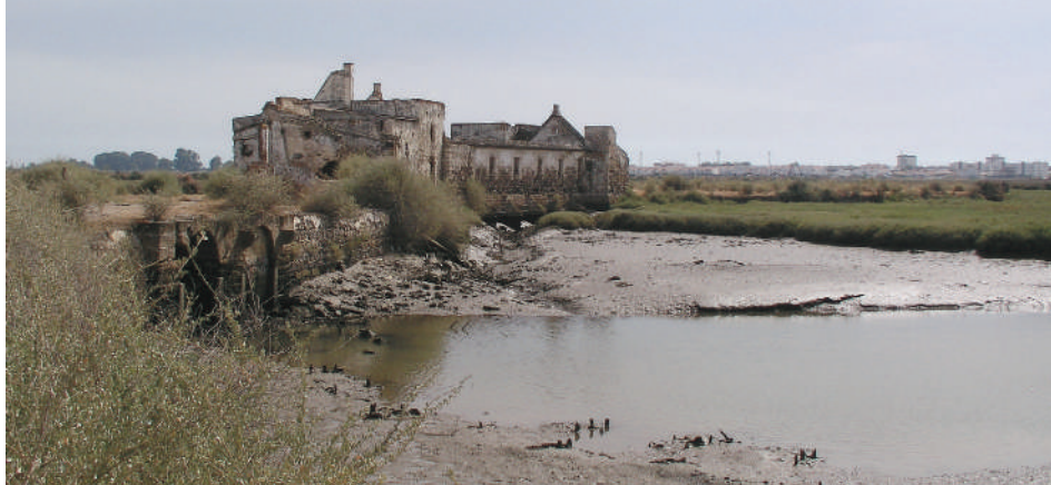
VISTA GENERAL DEL MOLINO Y EL PUENTE DE ACCESO
