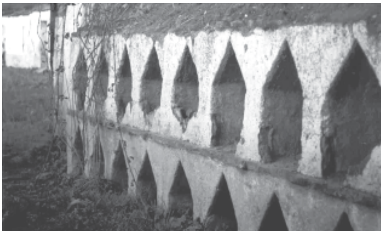
Detalle gallinero (Foto del autor)
