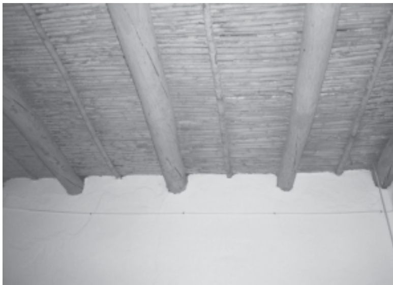
Detalle techumbre de caña (Foto del autor)
