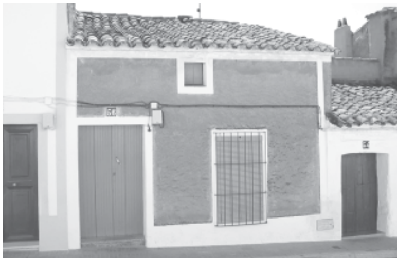
Detalle media casa (Foto del autor)
