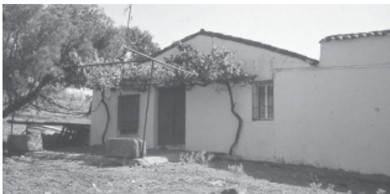
Fachada casa del guarda (Foto del autor)
