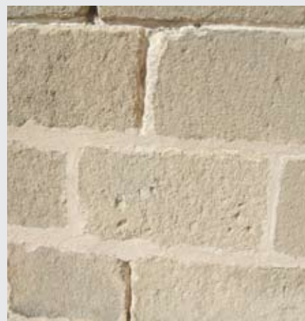
Aplicación del mortero seleccionado como material de juntas. Foto: Esther Ontiveros
