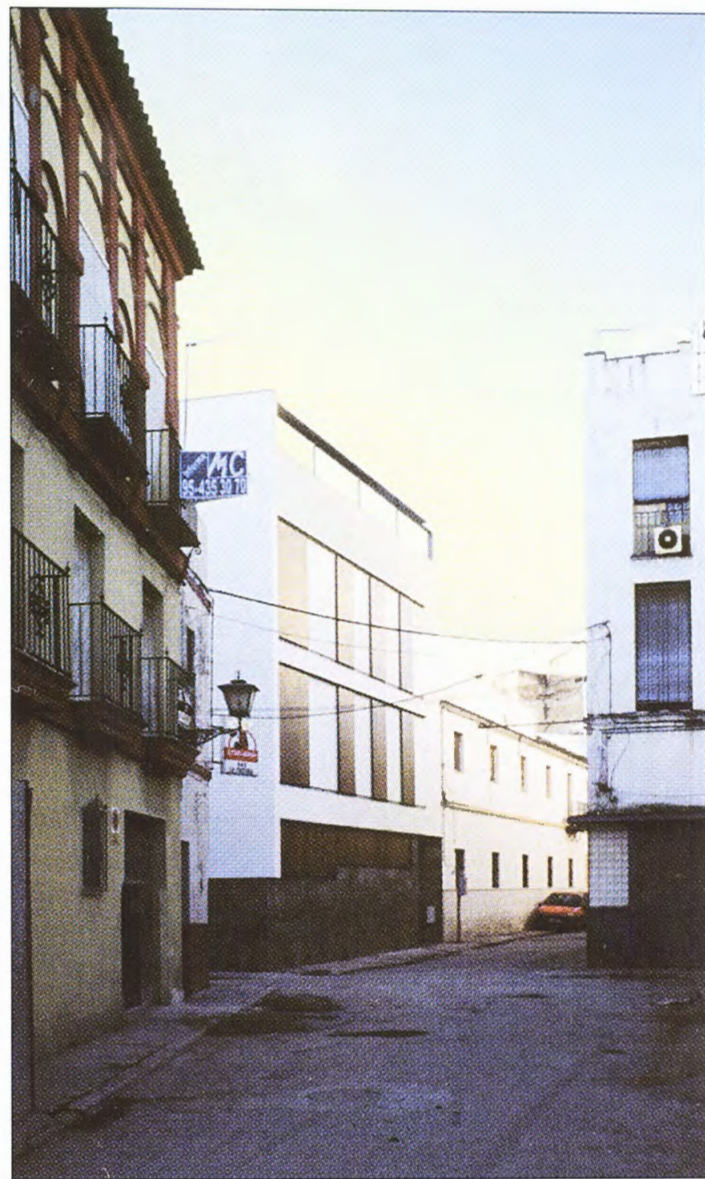
Las viviendas del barrio de la Alameda (Sevilla) de Antonio Tejedor y Mercedes Linares, promovidos por la Dirección General de Arquitectura y Vivienda de la Consejería de Obras Públicas y Transportes, aplican las existentes ordenanzas del Centro Histórico de la ciudad (vanos verticales, composición tradicional del zócalo, cuerpo y cornisa) con una interpretación contemporánea en los materiales y los elementos de cerramientos.
