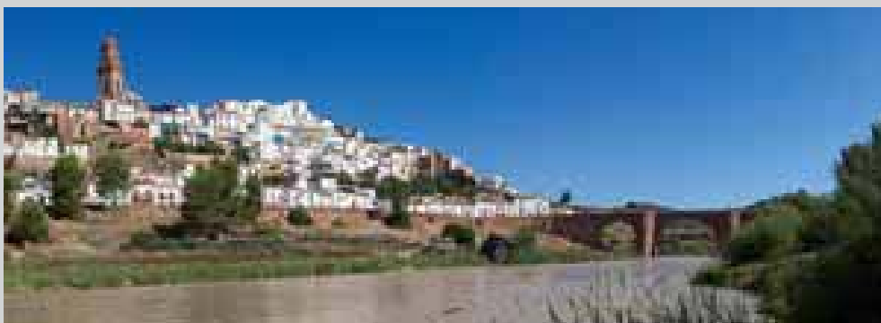
Puente sobre el Guadalquivir (Montoro). Foto: Juan Carlos Cazalla Montijano, IAPH
