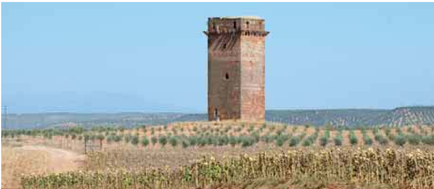
Torre de Villaverde (Montoro). Foto: Juan Carlos Cazalla Montijano, IAPH
