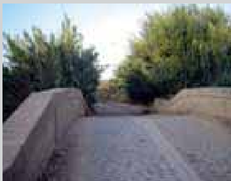
Puente sobre el río Pudio (Mairena del Aljarafe). Foto: Esther López Martín
