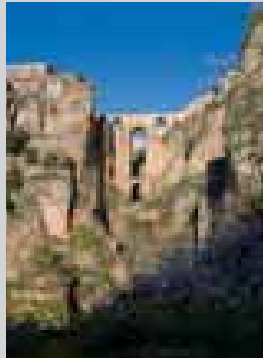
Puente sobre el tajo de Ronda. Foto: Isabel Dugo Cobacho
