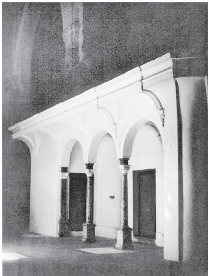
Lám. nº 6.- Tribuna del coro. Nave del Evangelio. Fototeca del Laboratorio de Arte de la Universidad de Sevilla, Registro 004690.
