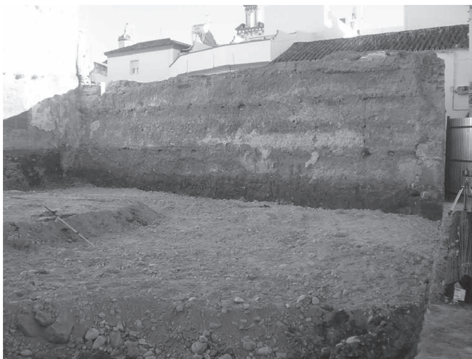
Lám. XV: Lienzo de la muralla almohade (Siglo XII-XIII), en la fachada de la calle Estepa. Supervisión Arqueológica en calle Arco de Belén esquina a calle Estepa.
