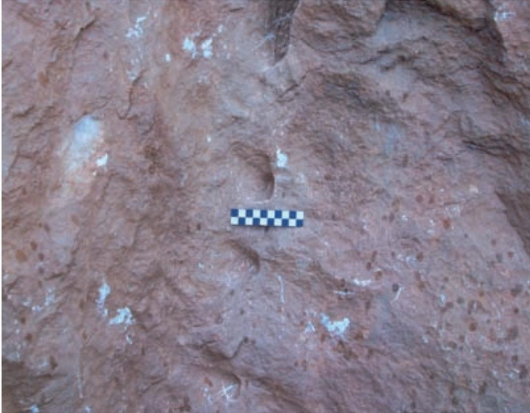
Figura 15. Detalle de orificios circulares, ejecutados con el puntero, para realizar posteriormente los canales para las cuñas, uno de los cuáles se aprecia arriba.
