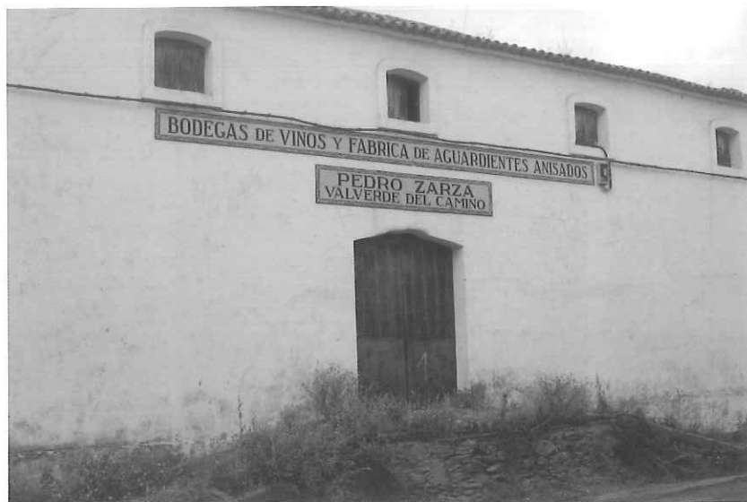
Detalle fábrica Zarza Mora. Valverde del Camino.
