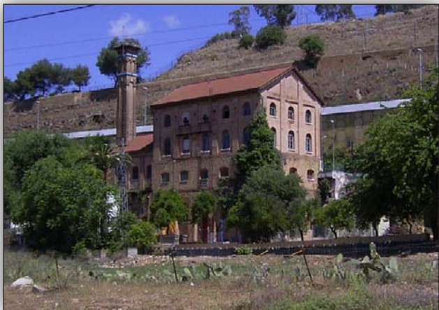
Edificio de Adufe construido por la compañía The Seville Water Works Company. Actualmente de EMASESA.
