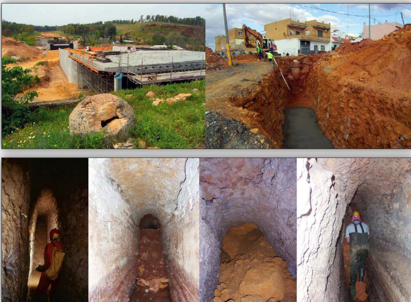
Afectaciones de obras modernas tanto en el interior como en el exterior del acueducto.
