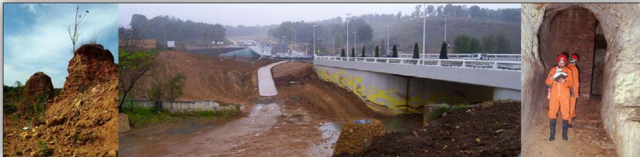
Actuaciones puntuales de obras en las que se ha tenido en cuenta la protección de elementos patrimoniales del acueducto.
