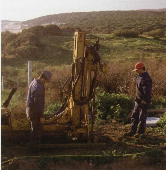
Figura 6. Equipo utilizado para la realización de los sondeos geotécnicos.
