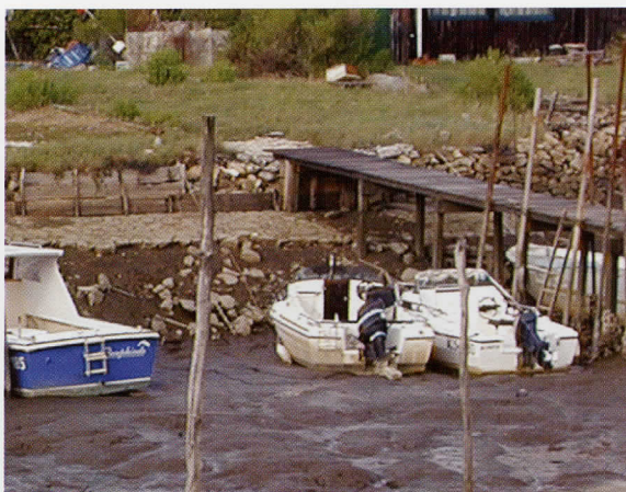
Figura 13. Embarcadero y rampa de la localidad de Arcachon (Aquitania, Francia). Obsérvese su similitud con la rampa de Bolonia, tanto por su técnica constructiva como por la disgregación que presentan sus elementos por efecto del mar.
