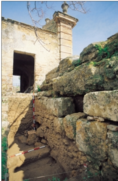
Adarve meridional con restos del recrecido en tapial.
