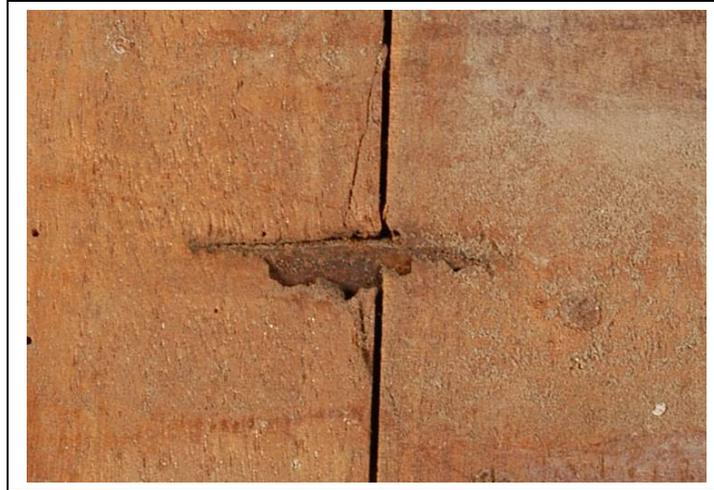
Espiga Metálica en unión de paneles
