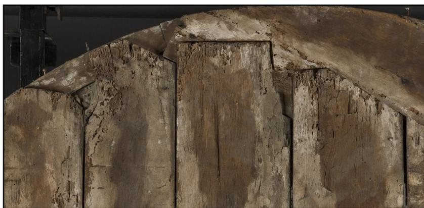
SISTEMA DE ENSAMBLE DE PANELES EN ZONA SUPERIOR
