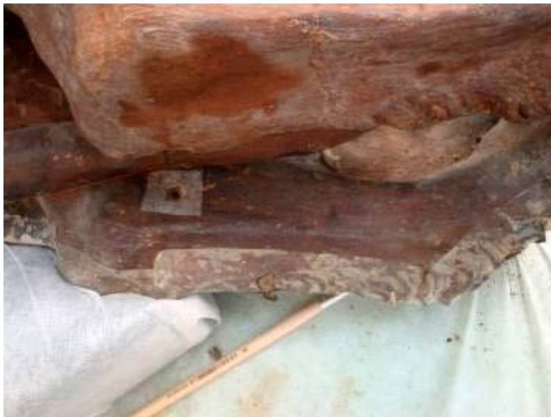
Agujeros originales para anclar las placas a un soporte.
