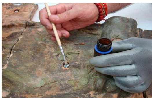
Sistema de anclaje de las placas al soporte de AEROLAM, y protección de los tornillos con paraloid B-72.
