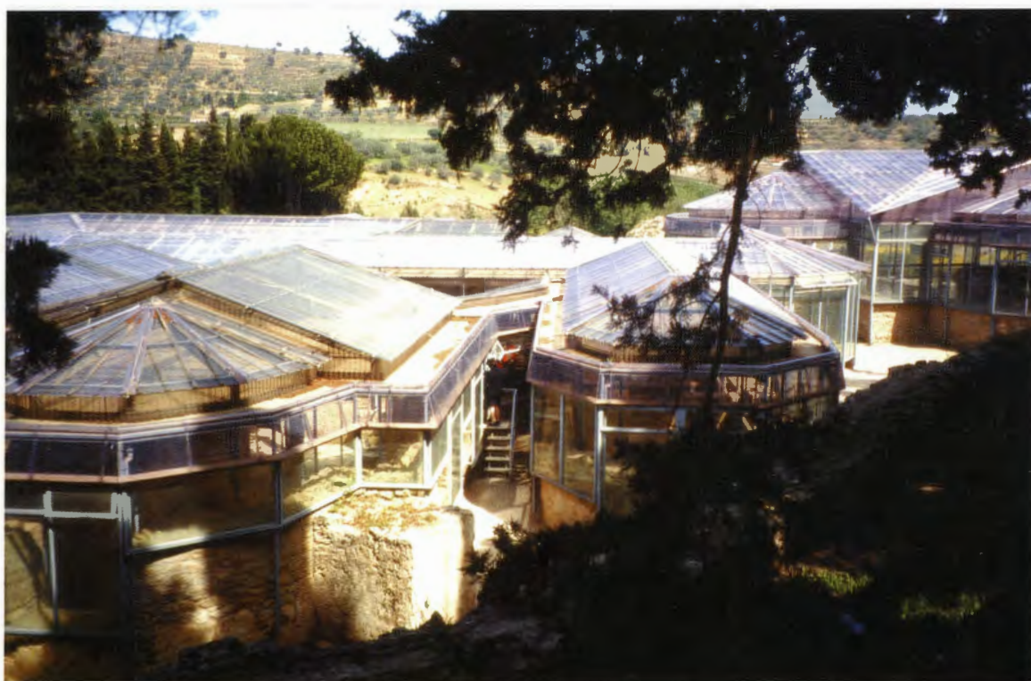
4. Piazza de Armerina, la Villa del Casale ha sido objeto de una polémica intervención, mediante la incorporación de una estructura ligera. Actualmente es un lugar sometido a un exceso de visitas turísticas.
