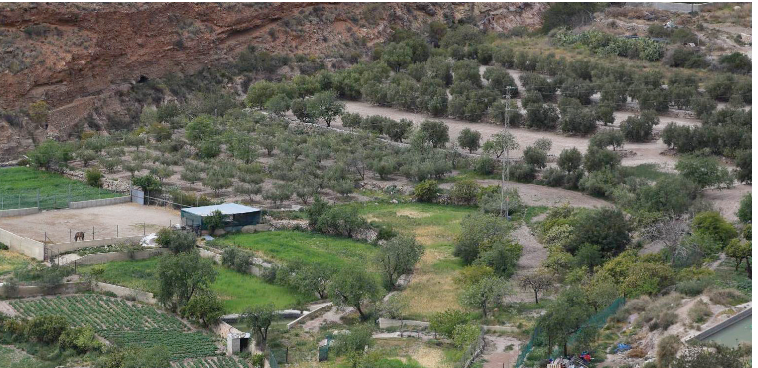
Arriba izq., atarjea de alimentación al cao de un molino de Huebro. Arriba dcha., huertas y fuente-cisterna de La Zanja, origen principal de las aguas para el regadío en el barranco. Abajo, panorámica de los aterrazados de Huebro en contacto con el escarpe de Sierra Alhamilla.
