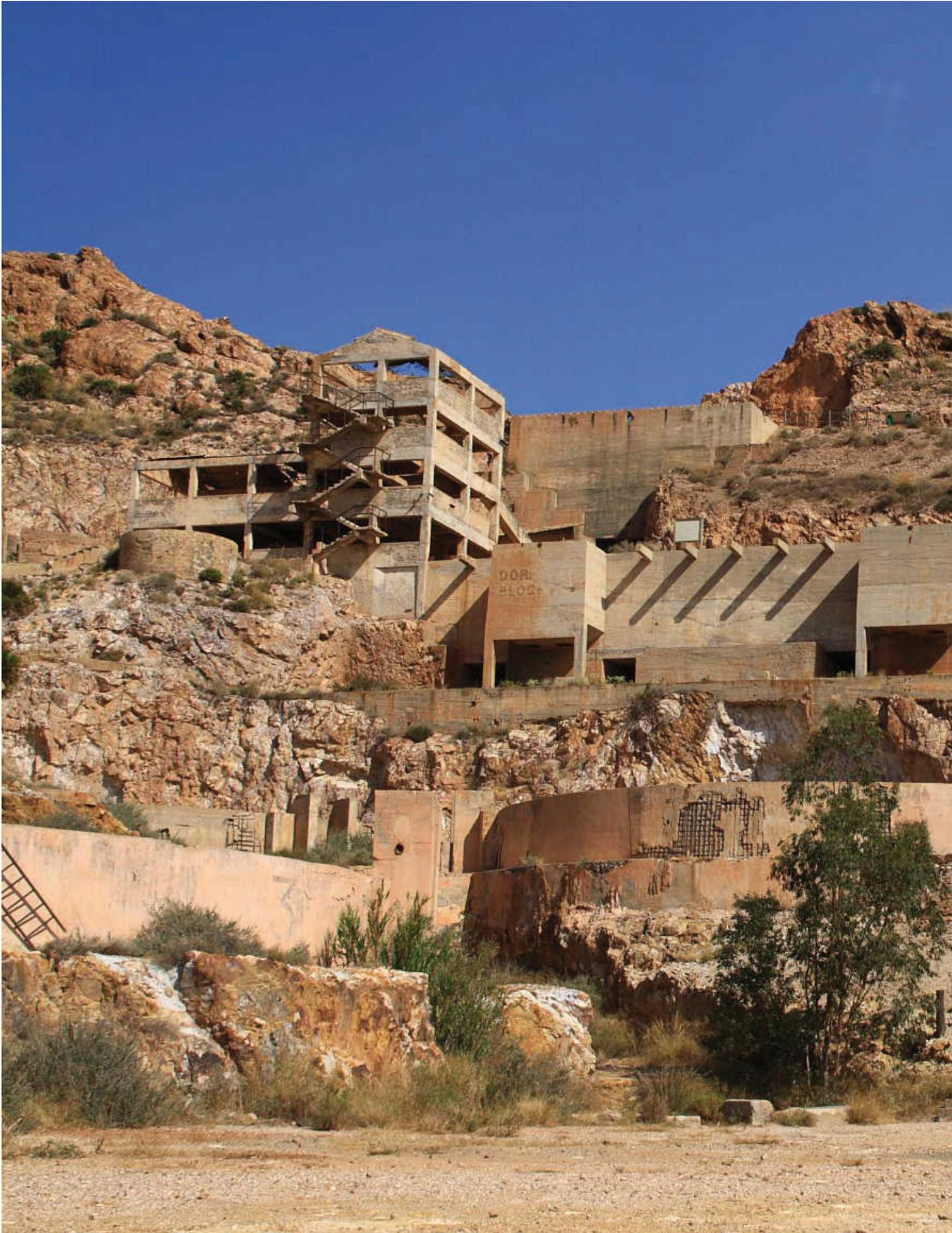
Vista general de la planta Denver, construida a mediados del siglo XX al norte del poblado de Rodalquilar. Se dedicaba al proceso de beneficio del oro mediante el método de la cianuración en balsas de decantación.
