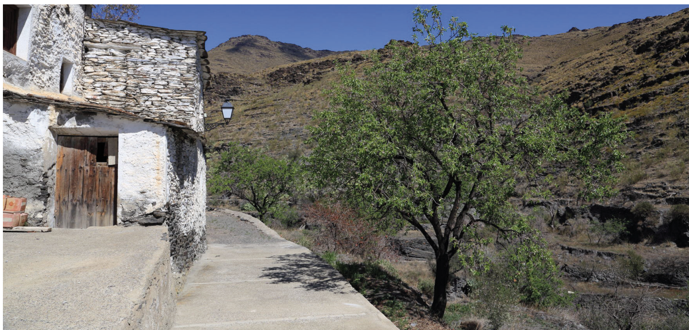
Vista de un sector del borde del casco urbano de Castro de Filabres.
