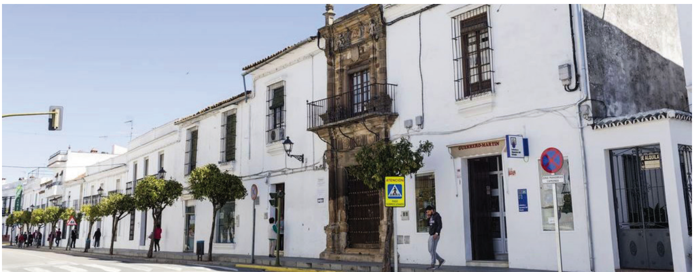
Vista de la casa-palacio de los Arnaud, del siglo XVI, en la calle Llana.
