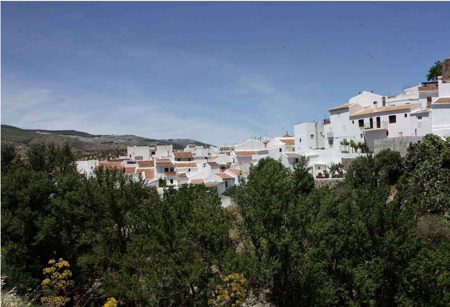
Perfil de la población conservando las estructuras defensivas al suroeste y la expansión histórica hacia poniente
