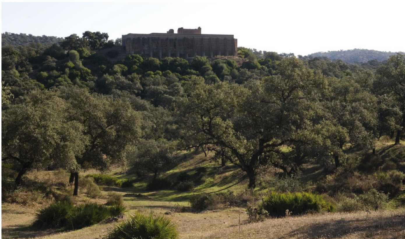
Vista del flanco occidental exterior de la ciudad romana hacia del “santuario” con el potente muro contrafuerte y los restos del templo en lo alto.
