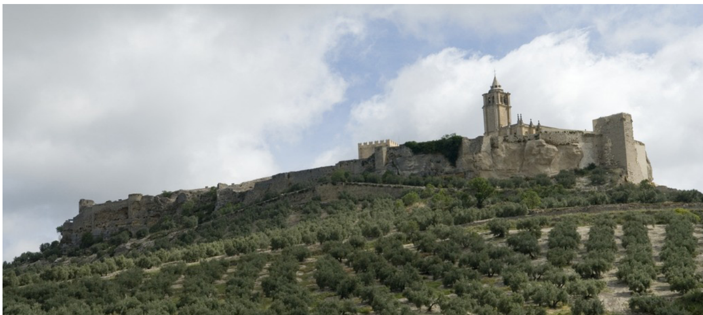
Conjunto Monumental de la Fortaleza de la Mota e iglesia de Santa María la Mayor
