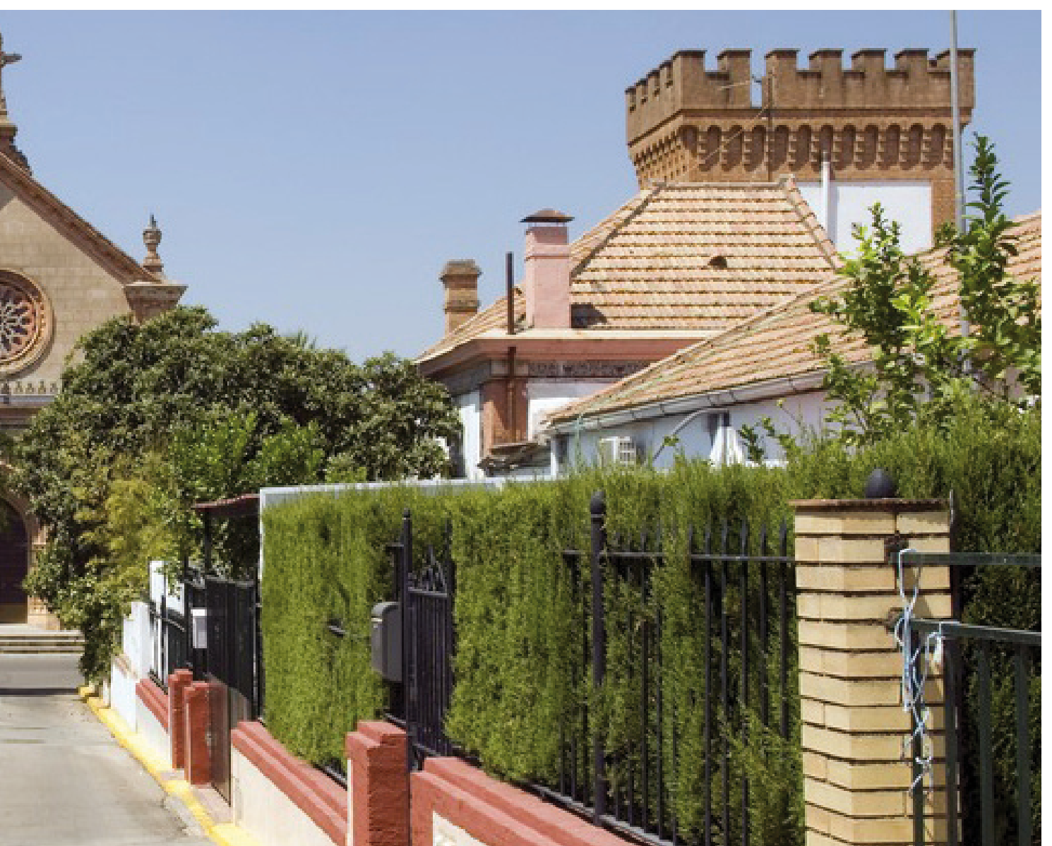
Arriba, vivienda del Ingeniero Jefe en el barrio de San Fernando-Cabrerizas.
