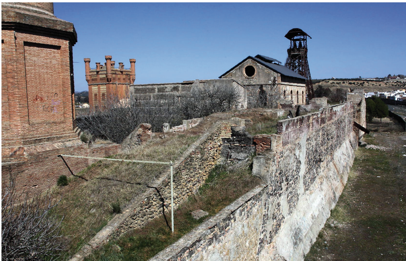
Vista parcial del Pozo n.º 5: base de una chimenea, el “castillete” o Central Térmica de 1926, la Cabria de 1898 y, en primer término, el edificio de carga de mineral.
