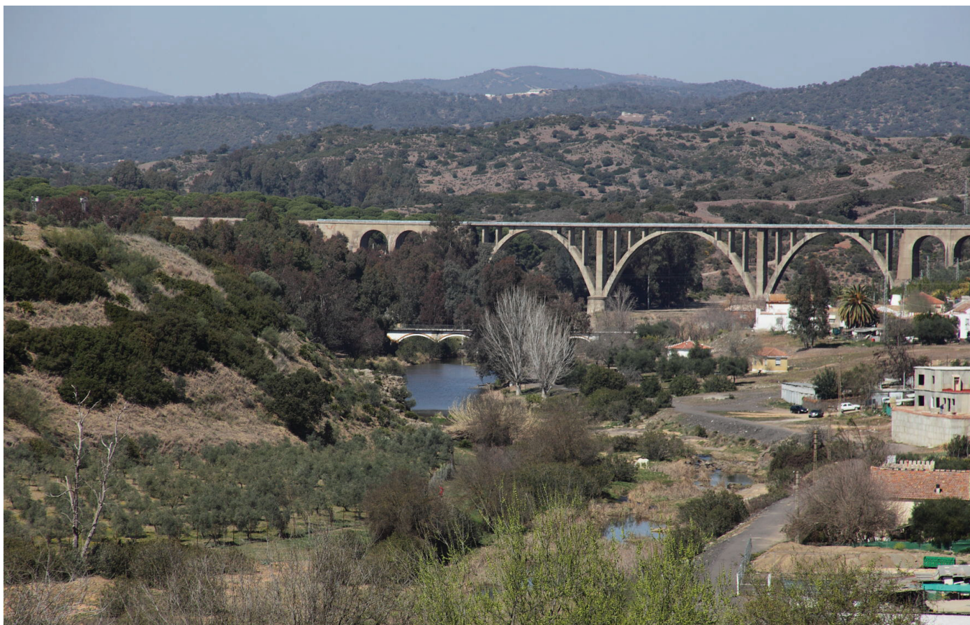
Vista general del límite urbano norte con el cauce de la Rivera del Huéznar y el puente ferroviario de 1952 que sustituyó a otro anterior de estructura de hierro.
