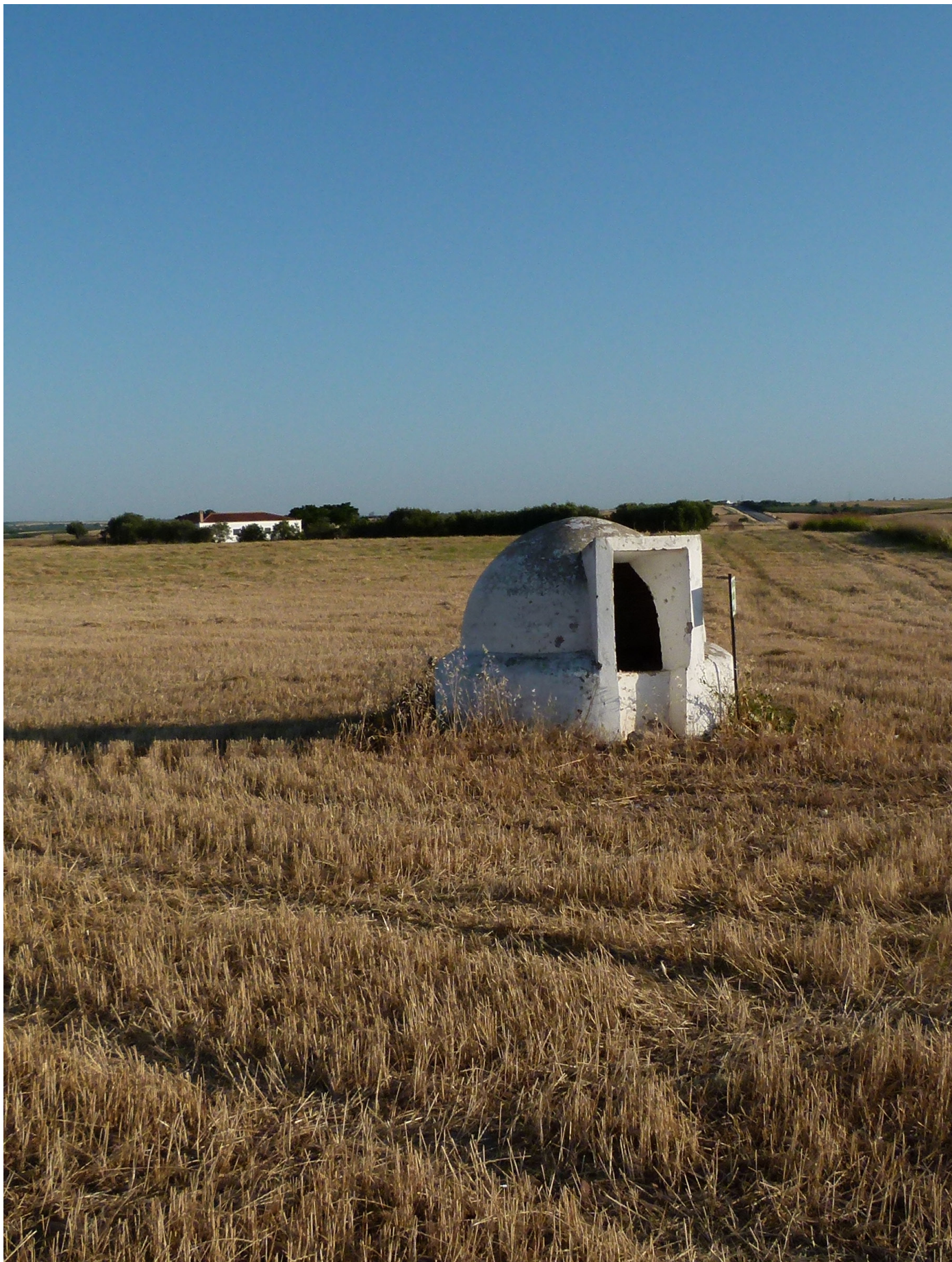
Pozo abovedado junto a la SE-3201
