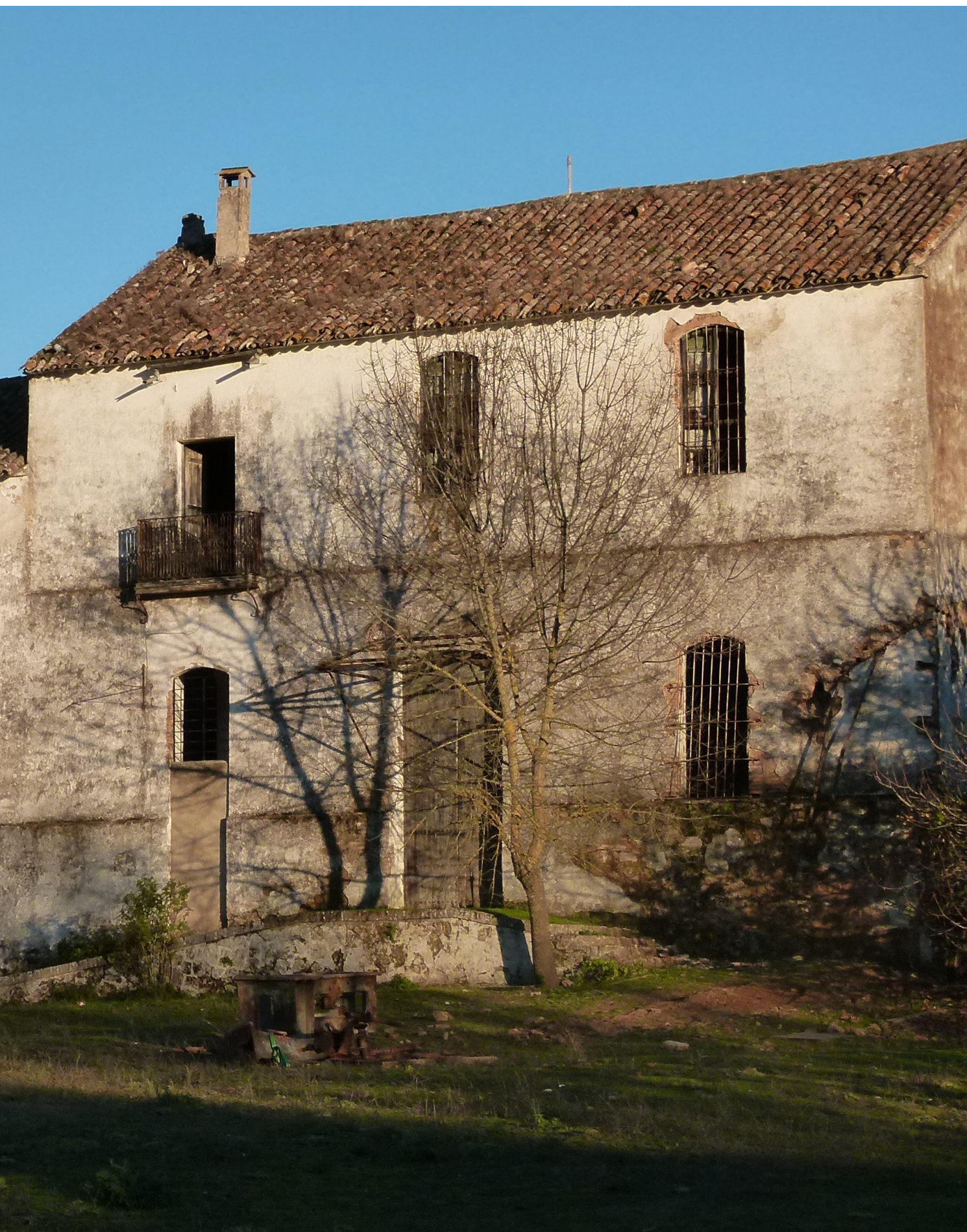
Central eléctrica del Carmen
