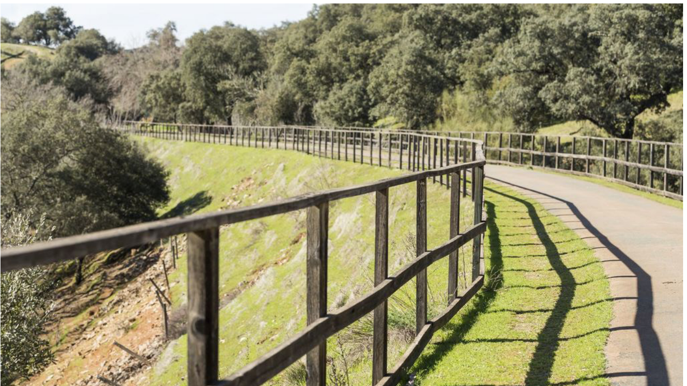
Tramo actual de la Vía Verde sobre la antigua línea de ferrocarril
