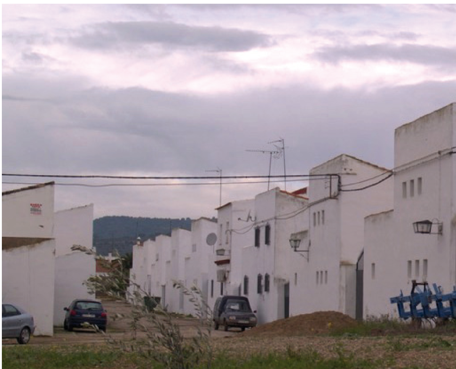
Arriba, fachada principal de la ermita de Setefilla. Abajo, panorámica del interior del poblado de colonización de Setefilla.
