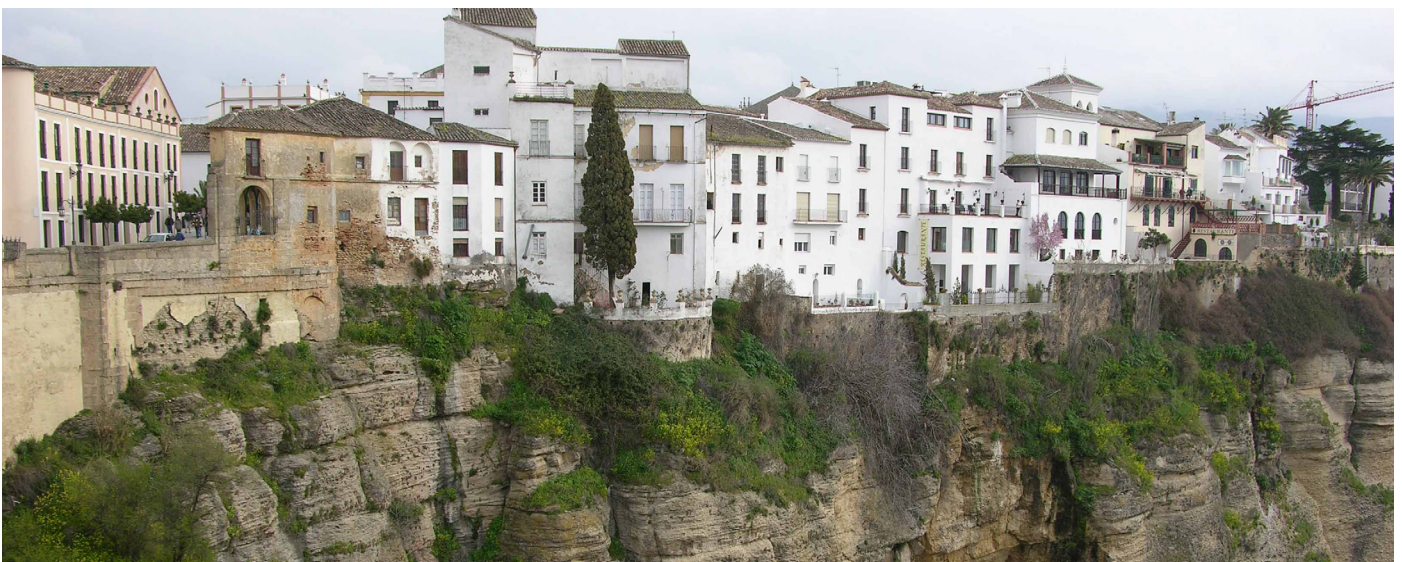
La primera línea del caserío sobre el cortado muestra un estado muy renovado de los inmuebles
