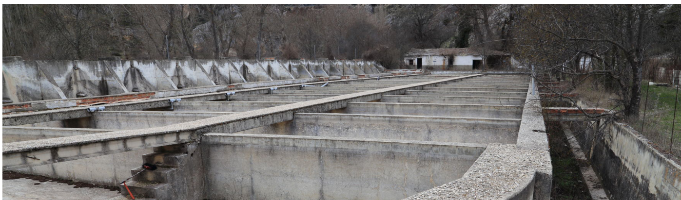
Instalaciones de la antigua piscifactoría
