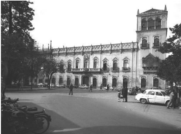
Palacio Sánchez-Dalp, Sevilla. Arquitecto: Simón Barris y Bes, 1916.
