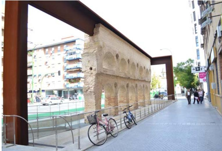
Tramo de los Caños de Carmona una vez restaurado. En la restauración se incorporó una viga metálica aérea para sujetar el canal y una barrera transparente para liberar la visión del monumento.
