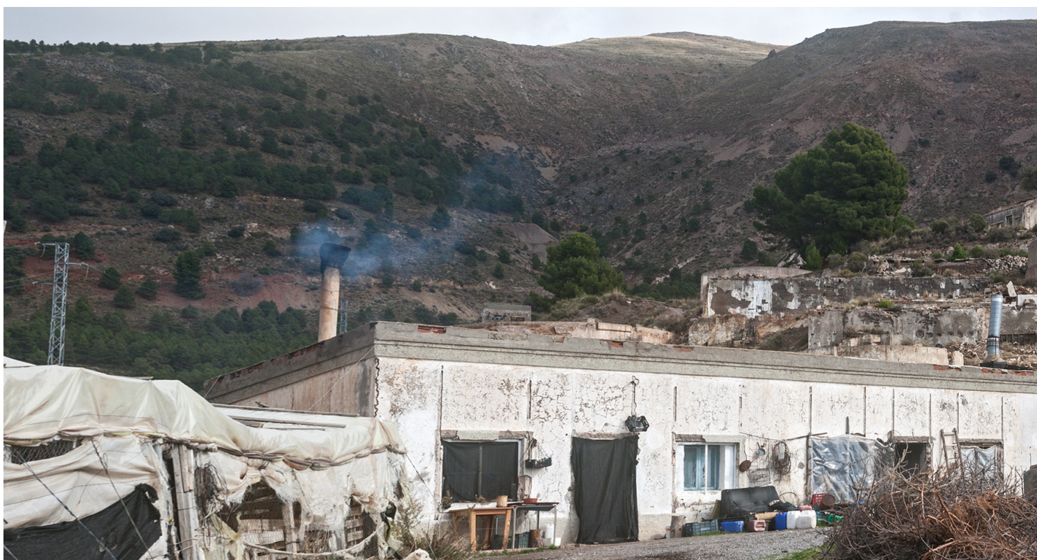
Arriba, Edificaciones de la instalación minera industrial de los lavaderos de El Segundo.
