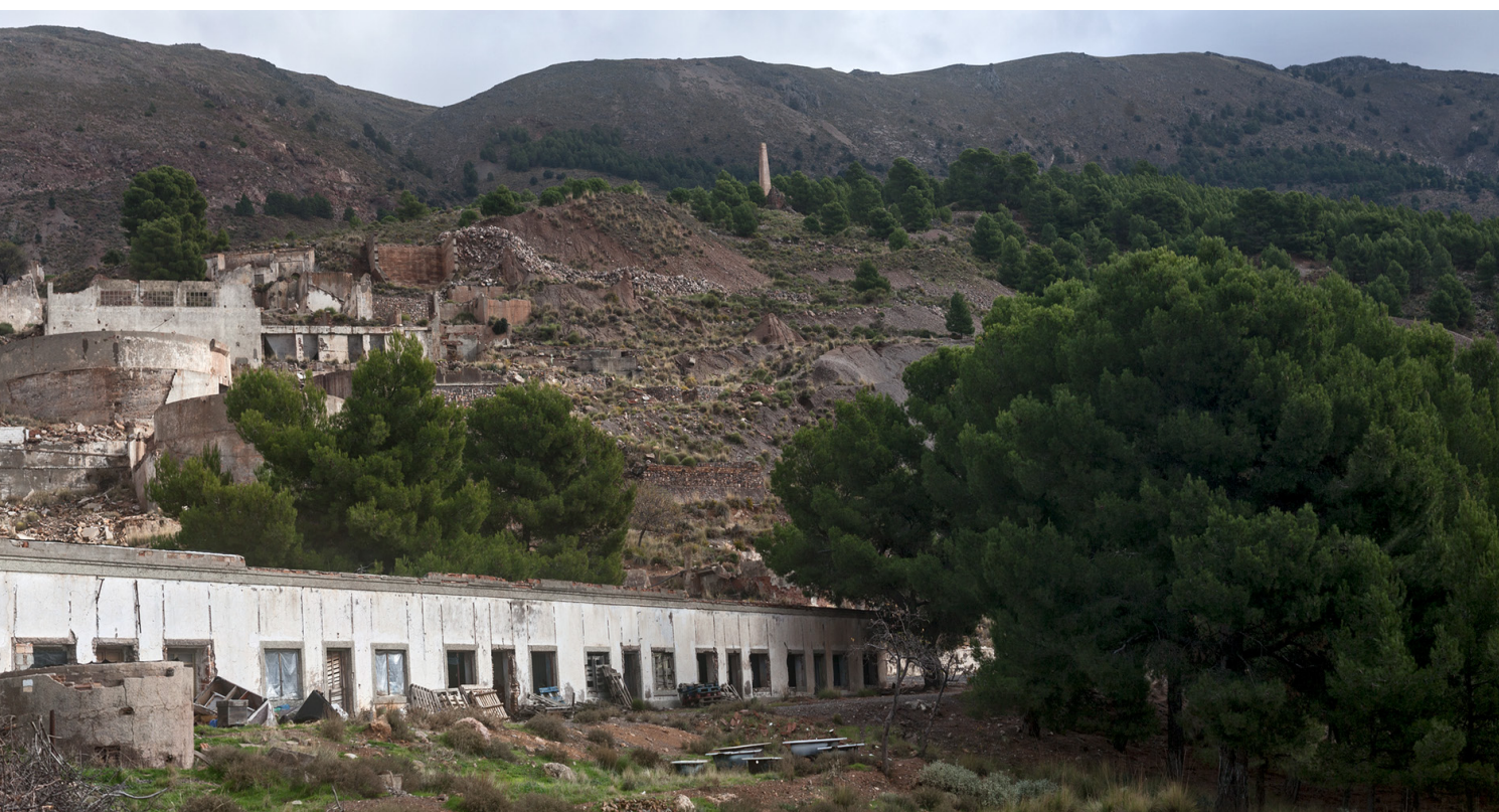
Panorámica general de las instalaciones de El Segundo.
