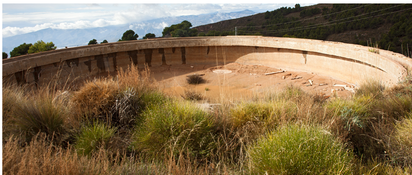
De arriba a abajo. Vista as escombreras del laboreo más reciente en El Segundo. Balsa tradicional para riego próximo a Castala. Balsas de sedimentación de fluorita en El Segundo.
