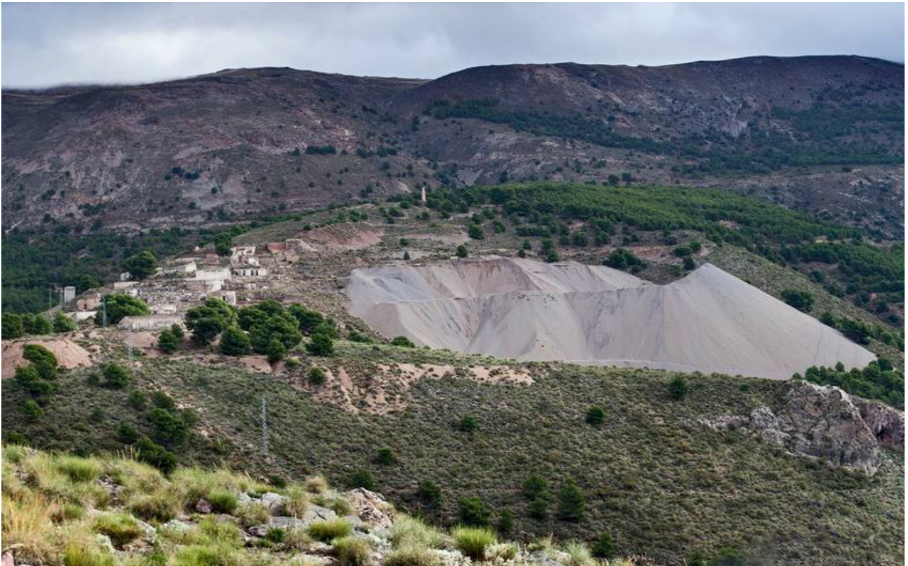
Escombrera y resto de las instalaciones y el poblado minero de la Fundición El Segundo.
