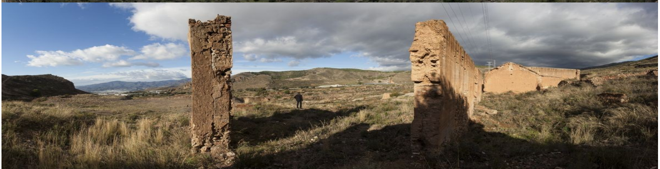
Panorámica de los campos de cultivo intensivo que ocupan en la actualidad parte del territorio minero y restos de algunas de las edificaciones que albergaron instalaciones en el complejo minero del Peñón de Castala.
