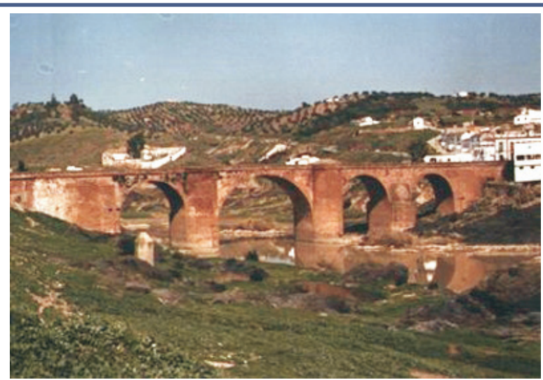
Puente sobre el Guadalquivir (Montoro). Dirección General de Bienes Culturales
