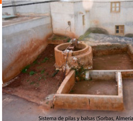
Sistema de pilas y balsas (Sorbas, Almería)
