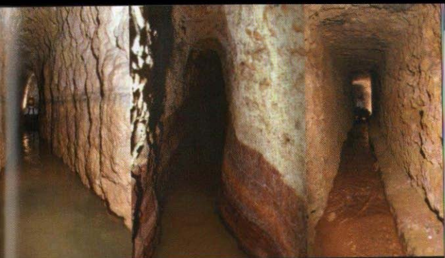
Algunos Tipos de Secciones en las Galerías.
