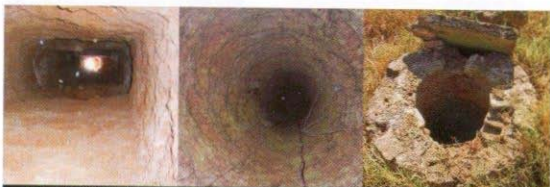
Formatos de lumbreras (interior y exterior)
