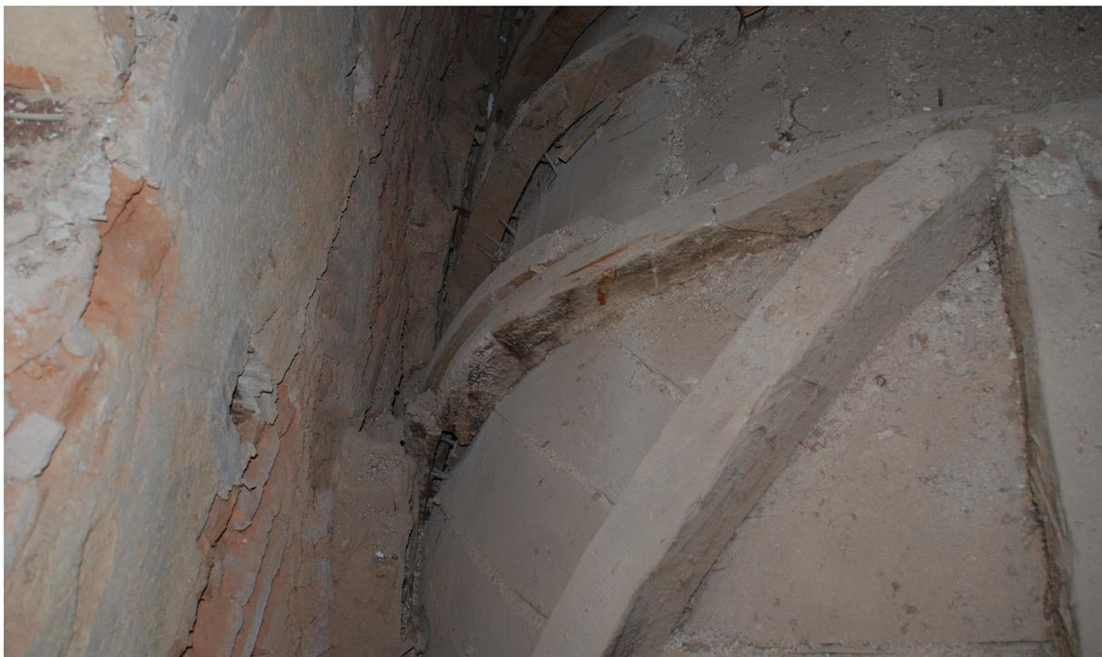
Figura 1. Vista del reverso de una de las bóvedas, donde se aprecian zonas con pudrición. Fotografía: Víctor M. Menguiano.
