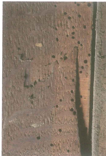
Fig. 1- Orificios de salida de anóbidos Fig. 2- Orificios de salida de anóbidos
