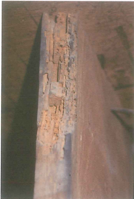
Fig. 1- Orificios de salida de anóbidos Fig. 2- Orificios de salida de anóbidos
