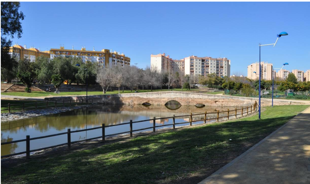
Figura 3: Alcantarilla del S. XVIII sobre el trazado recreado del arroyo Miraflores, en el parque periurbano del mismo nombre.
