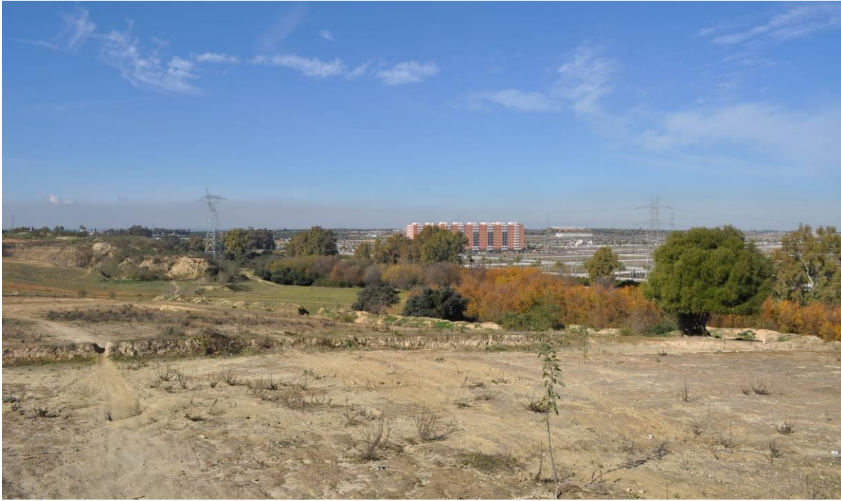
Figura 5: Ribera del arroyo Culebras con la conservación de su bosque galería. En primer plano, obras para el trazado de la SE-40. Al fondo, edificaciones del área urbanizada de Entrenúcleos. En el horizonte a la izquierda, casi imperceptibles, torres blancas de la hacienda Torre de Doña María. (Francisco José García, 2015)
