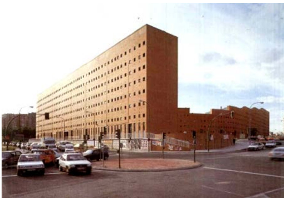
Viviendas en la M-30, vista exterior de los desniveles de la cornisa de la fachada, foto de época.
