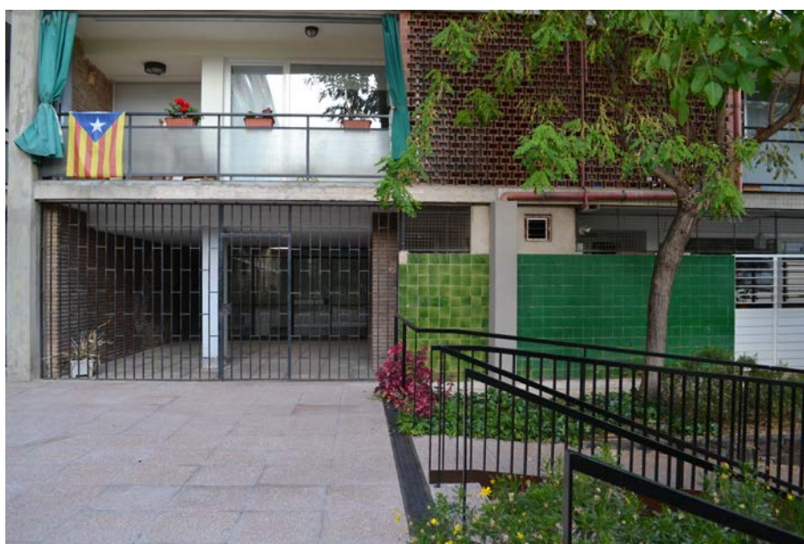
Grupo residencial Escorial, vista exterior espacio común planta baja bloque B, 2018. Foto: María Luisa Reigal.
