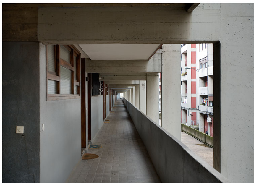
Conjunto de viviendas protegidas Pedro Astigarraga, detalle vista calle elevada, 2008. Fundación DOCOMOMO Ibérico. Registro Vivienda, PV_A14_24. Foto: Luis Argüelles.
