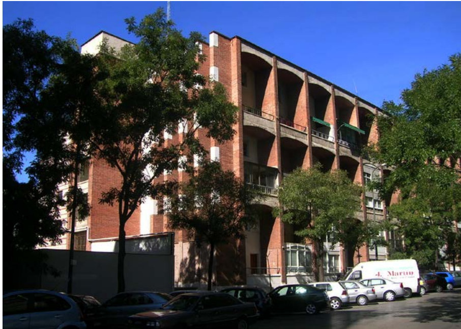
Edificio de viviendas dúplex en la Colonia Virgen del Pilar, detalla ingreso y alzado lateral sur, desde calle Mataelpino. Fundación DOCOMOMO Ibérico. Registro Vivienda, MA_A12_6.
