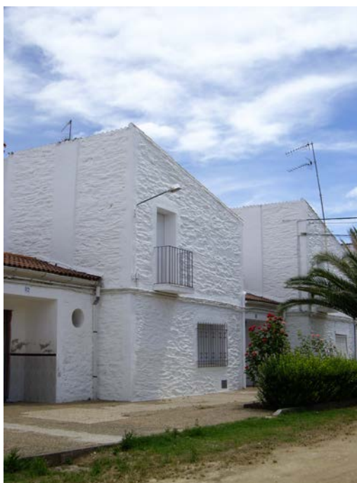
Poblado de colonización Vegaviana, vista exterior fachadas, estado actual. Fundación DOCOMOMO Ibérico. Registro Vivienda, EXT_A1_3.
