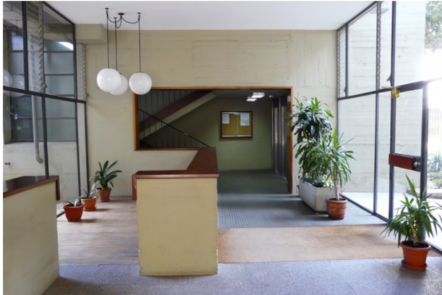
Grupo residencial Escorial, vista interior espacio común de acceso de la torre, bloque A, 2017. HIC Arquitectura, Grupo Escorial, 1955. Foto: Stefano Carlo Ascione.
