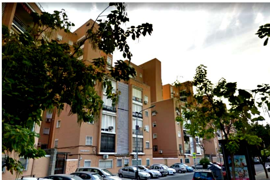
Conjunto de viviendas Los Diez Mandamientos, vista exterior del conjunto calle Malvaloca, 2018.
