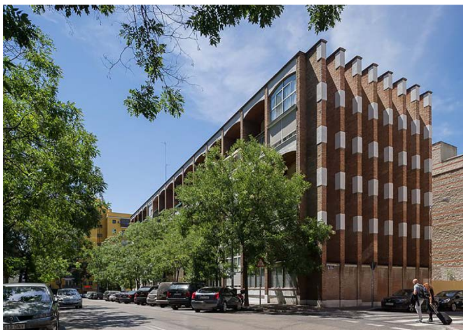
Edificio de viviendas dúplex en la Colonia Virgen del Pilar, vista exterior fachada principal y fachada lateral, calle Mataelpino, 2017.
