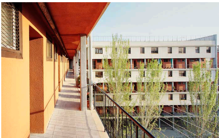
Casa Bloc, vista de los corredores de acceso a las viviendas, 2008. Fundación DOCOMOMO Ibérico. Registro Vivienda, CAT_A8_5. Foto: José Hevia.
