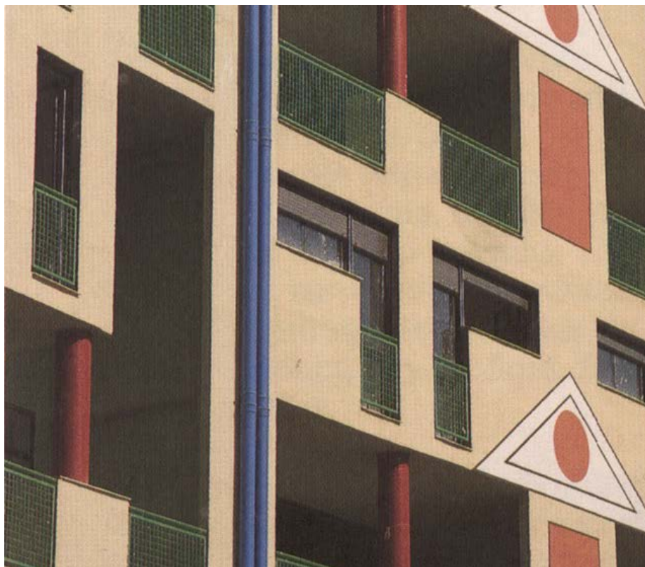
Viviendas en la M-30, vista detalle de la composición de la fachada interior, foto de época.
