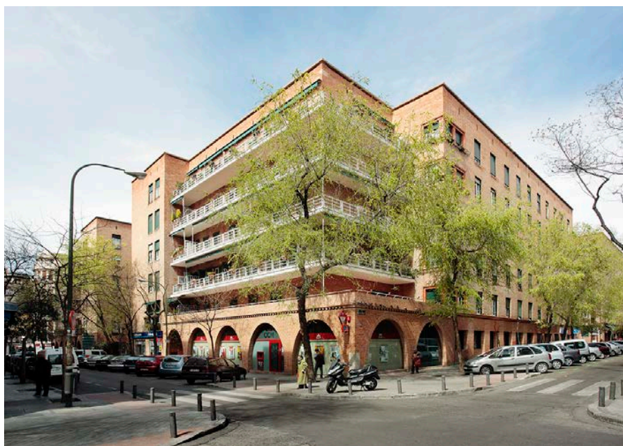
Casa de las Flores, vista exterior del edificio desde calle Rodríguez San Pedro, 2008. Fundación DOCOMOMO Ibérico. Registro Vivienda, MA_A2_35. Foto: José Hevia.
