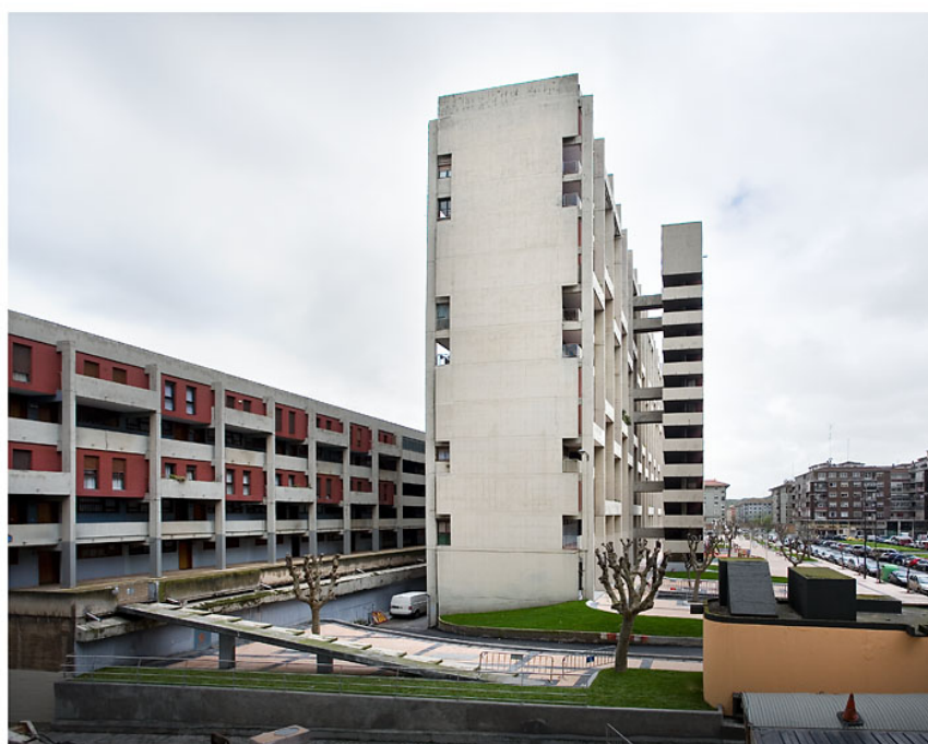
Conjunto de viviendas protegidas Pedro Astigarraga, vista exterior del conjunto desde calle Luis Braille, 2008. Fundación DOCOMOMO Ibérico. Registro Vivienda, PV_A14_4. Foto: Luis Argüelles.
