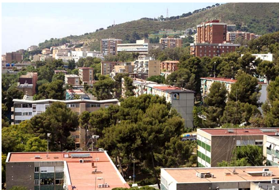
Barrio de Montbau, vista exterior general desde las viviendas en L de la segunda fase del conunto.
