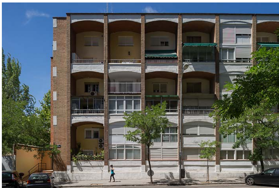
Edificio de viviendas dúplex en la Colonia Virgen del Pilar, detalla vista frontal fachada principal e acceso de ingreso, desde calle Mataelpino, 2017. Foto: Xavier de Jauréguiberry.
