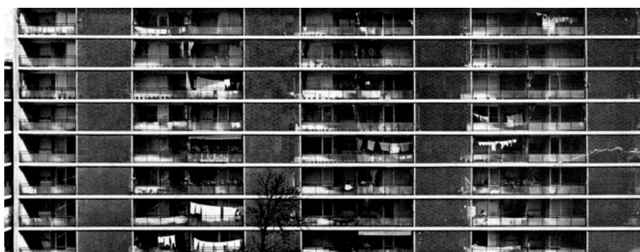
Grupo residencial Escorial, detalle fachada hacia espacio público bloque B. Fundación DOCOMOMO Ibérico. Registro Vivienda, CAT_A20_15. Cuadernos de Arquitectura , 1963 (4º trimestre), nº. 54.
