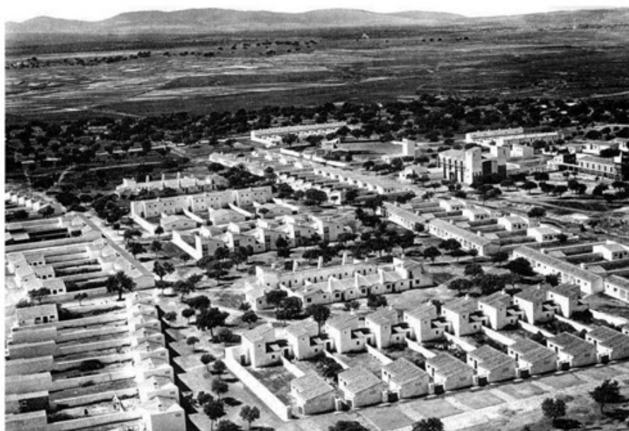
Poblado de colonización Vegaviana, vista área del conjunto, foto de época. CÁNOVAS, A., ESPEL, C., DE LA PUERTA, J.M., MARTÍNEZ ARROYO, C., PEMJEAN, R. (2013). Vivienda Colectiva en España Siglo XX (1929-1992) . Valencia: General de Ediciones de Arquitectura, p.81.
