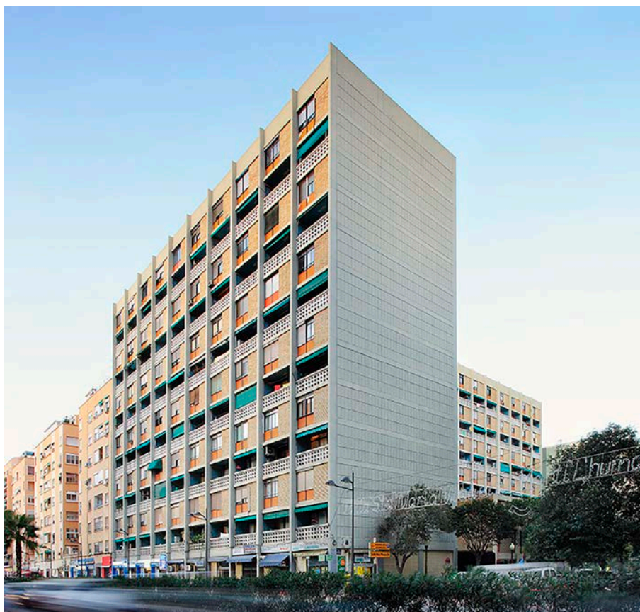
Grupo de Viviendas para la Cooperativa de Agentes Comerciales, vista exterior conjunto. Fundación DOCOMOMO Ibérico. Registro Vivienda, VA_A46_3. Foto: José Hevia
