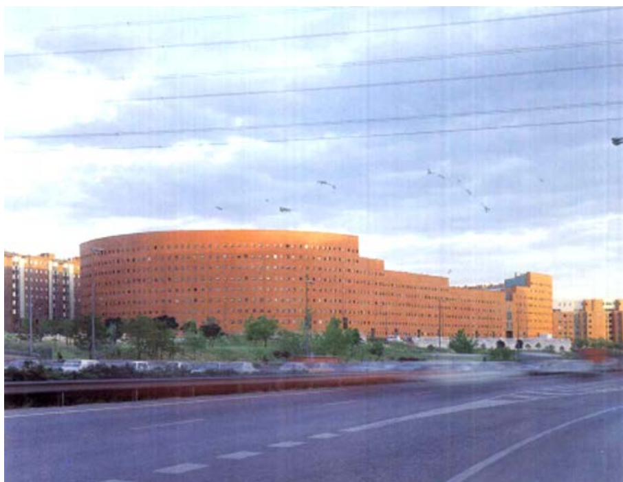
Viviendas en la M-30, vista general alzado exterior, foto de época.
