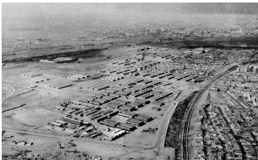
Poblado dirigido de Entrevías: imagen general del conjunto. Instituto Nacional de la vivienda, 1963.
