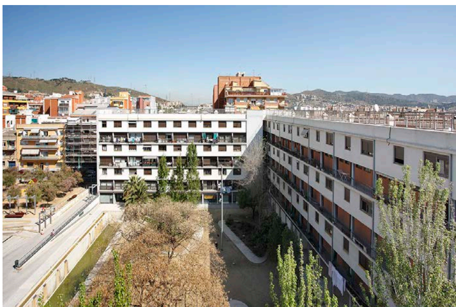
Casa Bloc, vista general del bloque y del espacio público, 2008. Fundación DOCOMOMO Ibérico. Registro Vivienda, CAT_A8_49. Foto: José Hevia.
