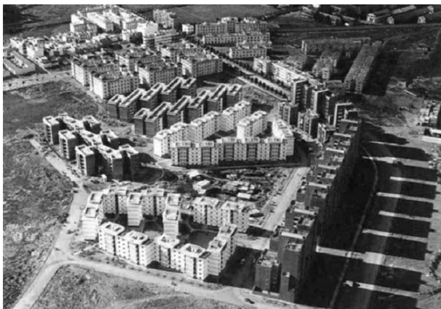
Conjunto de viviendas Los Diez Mandamientos, vista general del conjunto durante la construcción del nuevo tejido de la periferia, foto de época.
