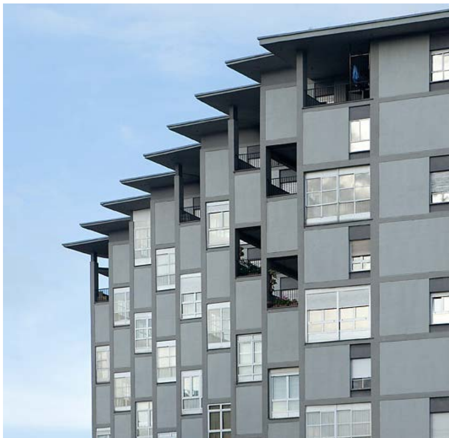
Edificio de viviendas Alsa, vista exterior de fachada residencial, 2008. Fundación DOCOMOMO Ibérico. Registro Vivienda, AST_A10_38. Foto: Luis Argüelles.
