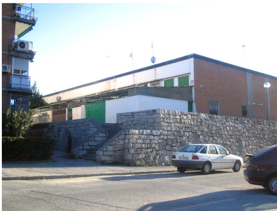
Poblado dirigido de Entrevías, vista general del alzado de una unidad tipo. Fundación DOCOMOMO Ibérico. Registro Vivienda, MA_A23_10.
