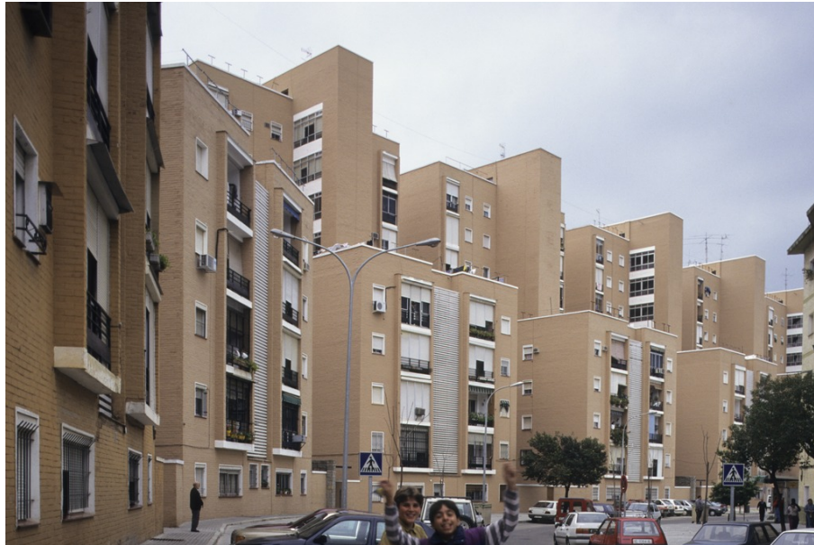
Conjunto de viviendas Los Diez Mandamientos, vista fachadas conjunto desde calle Malvaloca, foto de época. IAPH, repositorio de activos digitales del IAPH, código (19288). Foto: Javier Romero García.
